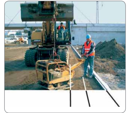
Der Griff der Rüttelplatte lässt sich hochstellen und arretieren – selbst wenn die Last ein wenig hin- und herpendelt, kann nichts passieren. Es muss daher niemand nebenherlaufen und den Griff festhalten.
